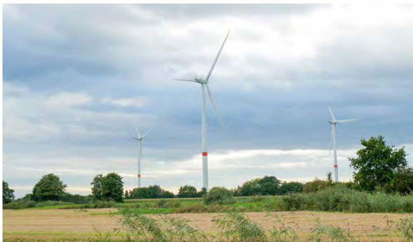
Windkraftanlagen von E.ON.
