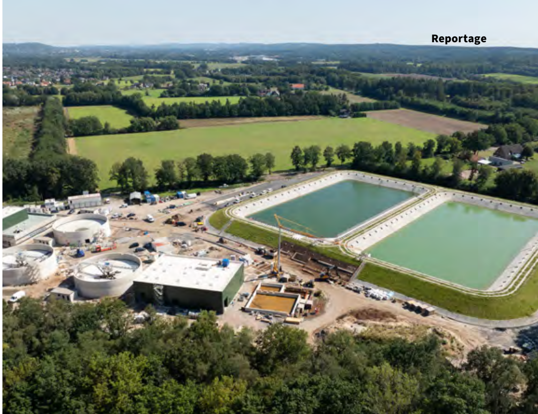
Die neue Kläranlage bereitet Grubenwasser auf, das aus dem alten Bergwerk kommt und etwa Salze und Mineralien enthält.
