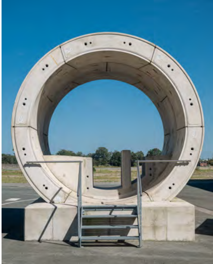
Diese Tunnелеlemente (links) werden im Kanal (rechts) verbaut. Das Grubenwasser fließt darin später nur in den unteren beiden Rinnen.
