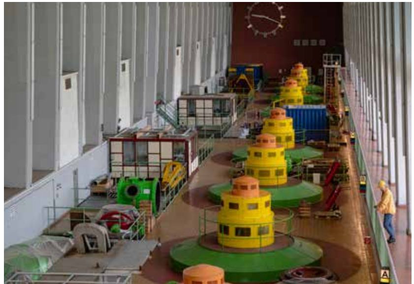
Die acht Maschinen von Hohenwarte II haben eine Gesamtleistung von 320 Megawatt.
