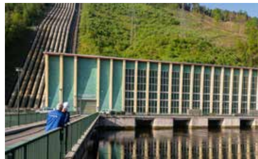
Hohenwarte II an der Talsperre Eichicht.
